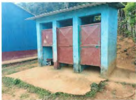
Foto 7: MODULO II: Aplicación de Pintura de pared, interior y exterior y mantenimiento de estructura de baño y Sustitucion de lámina troquelada C26.
