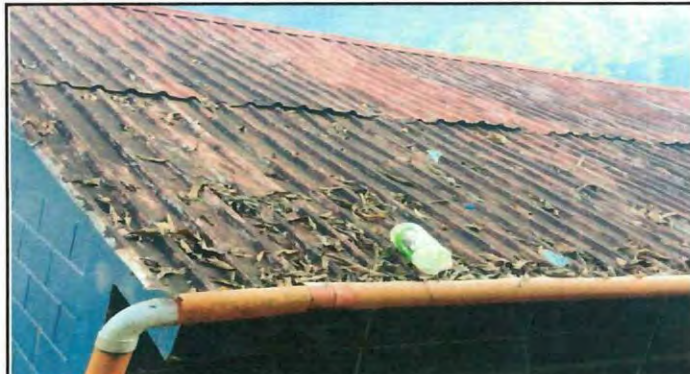
Foto 2: MODULO I: Sustitución de láminas acanaladas a troqueladas.
