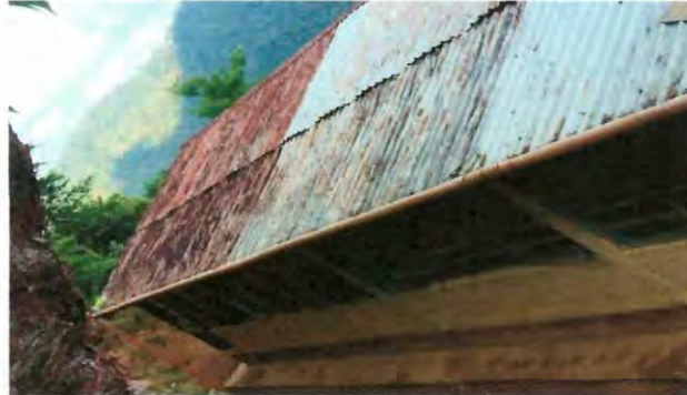
Foto 8: MODULO III: Instalación de nuevo canal pvc.
