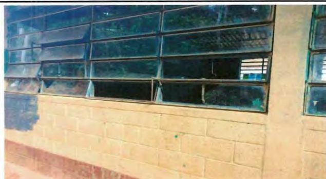
Foto 3: MODULO I: Mantenimiento de balcones, (barroteado, lijado y aplicación de pintura azul nacional.)
