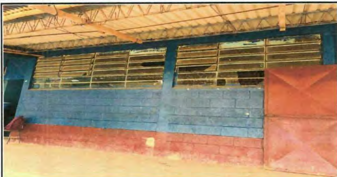
Foto1: MODULO I. Cambio de estructura metálica.
