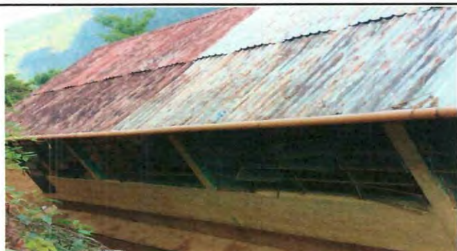
Foto 5: MODULO I: Aplicación de pintura en muros interiores y exteriores
