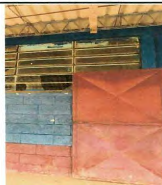
Foto 4: MODULO I: Cambio de puertas de metal
